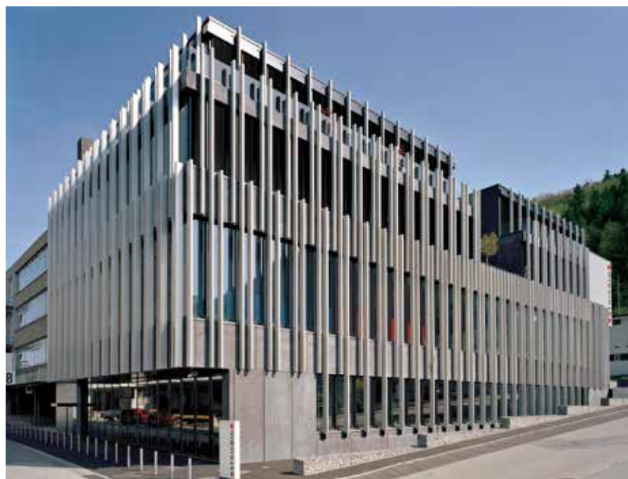
Uma identidade empresarial montada. Contrafortes de pilar de alumínio verticais formam a fachada da nossa sede em Littau, Lucerna, e representam uma boa relação com os nossos produtos e parceiros de mercado.
